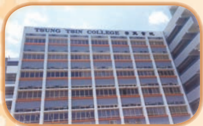
校舍外牆翻新工程
